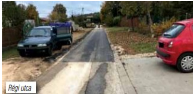
4. ábra – Régi utca felújítása
